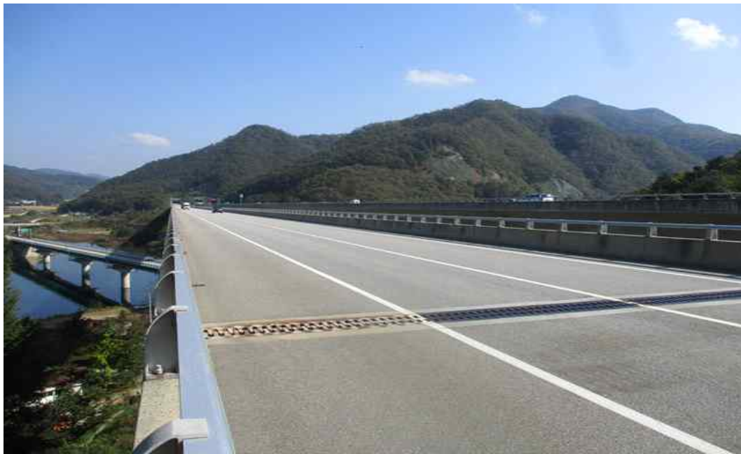
발산1교(서울) 상부 전경
