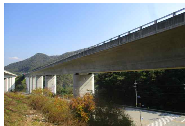
발산1교(양양) 측면 전경
