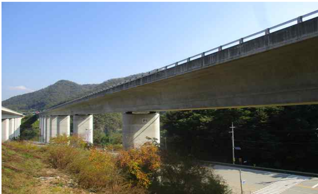
발산1교(양양) 측면 전경
